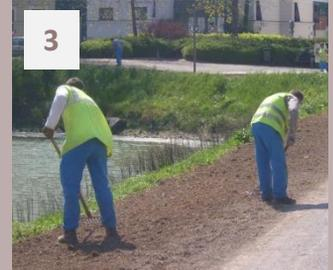
3 Die Oberfläche mit Hilfe einer Harke oder eines Vierzahns verfeinern
