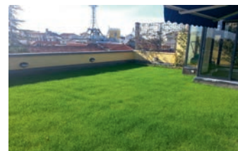
Pratens im Rahmen einer Dachbegrünung
