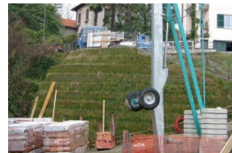
Bewehrte Erde – Bauphasen
