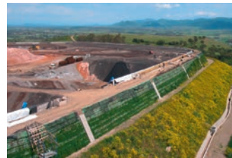
Bewehrte Erde im Rahmen eines Deponieprojektes (Sardinien)
