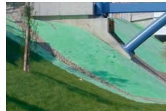
Baustelle Wiener Südosttangente, Begrünung rund um die Brückenköpfe
