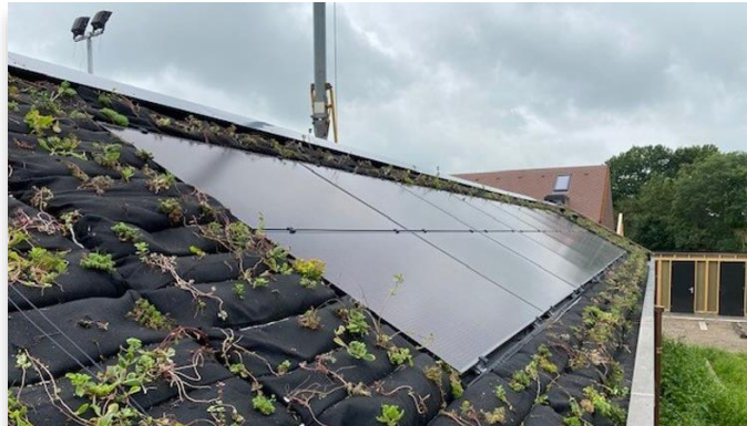
Nach Installation | Vianen, NL
